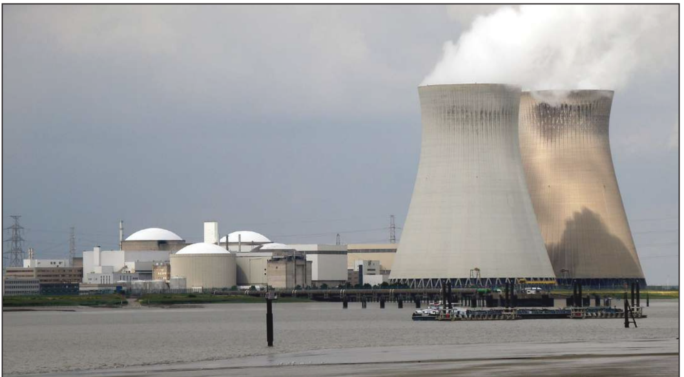
Centrale nucléaire de Doel, 2013
